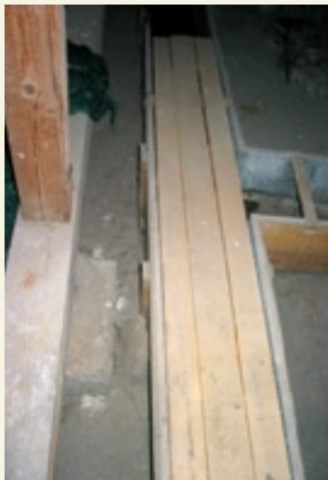
38. Deszkával borított vízelvezető/ attikacsatorna a padlástérben
