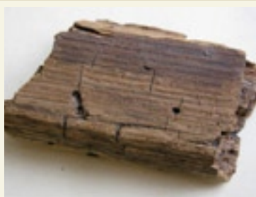
4. Templom tetőszerkezetéből származó, gombakárt szenvedett fa, a korhadásra jellemző, „kockás” repedésekkel
